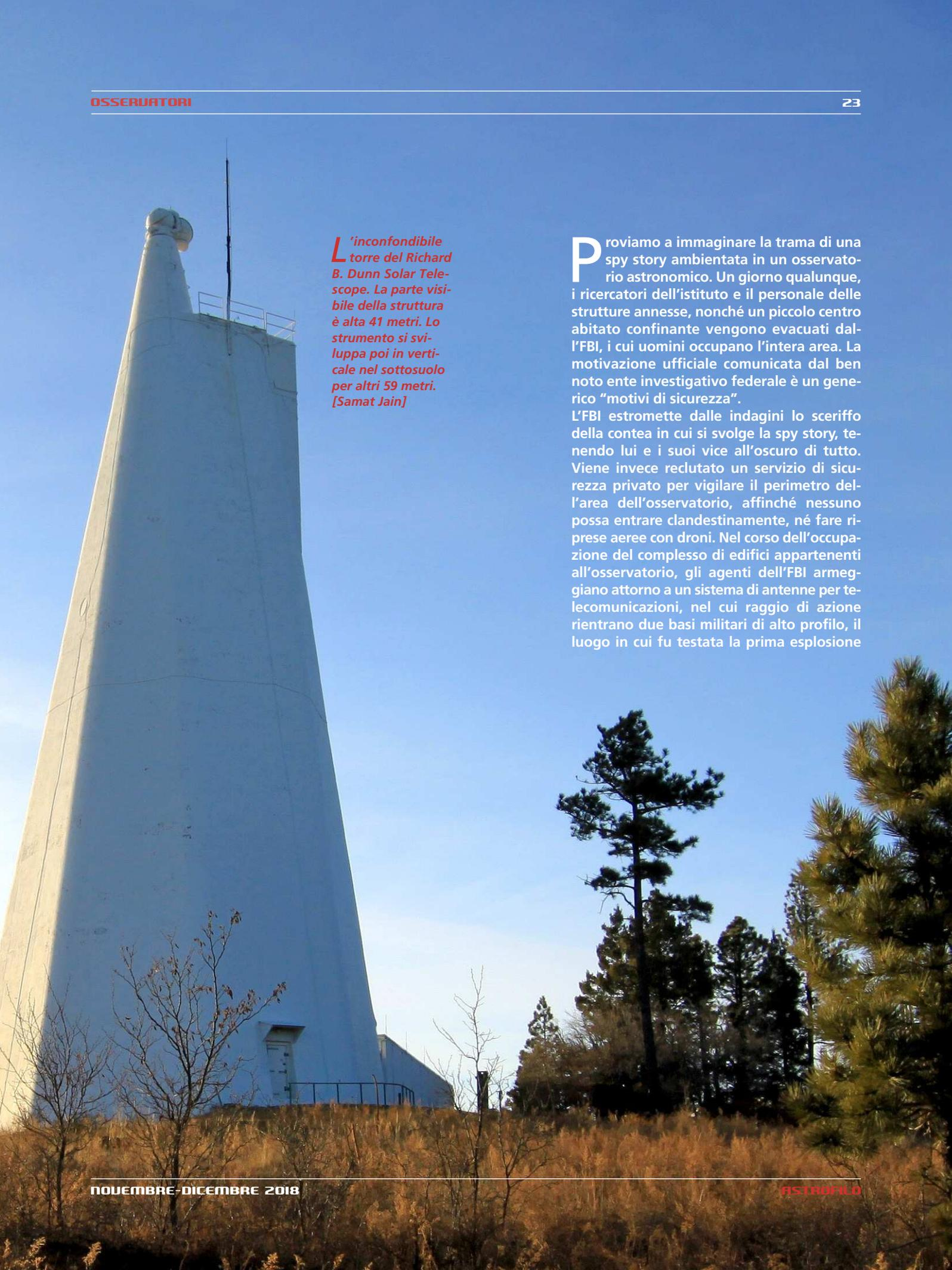
**L'**inconfondibile torre del Richard B. Dunn Solar Telescope. La parte visibile della struttura è alta 41 metri. Lo strumento si sviluppa poi in verticale nel sottosuolo per altri 59 metri. [Samat Jain]
